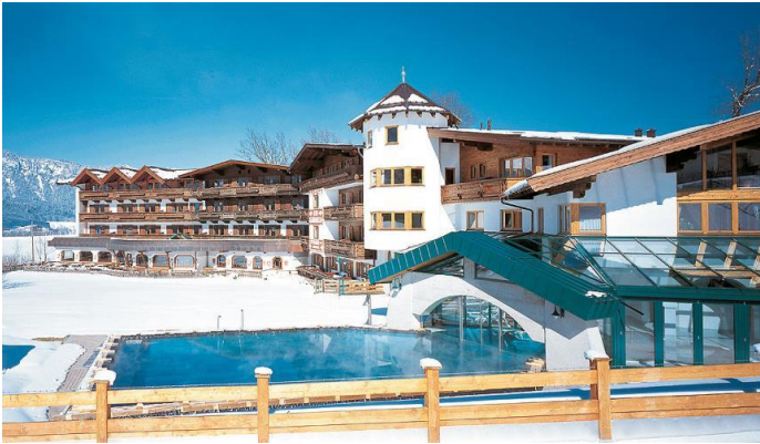
Das 4 **** Hotel „Kitzbühler Horn“ mit Außen/Innenschwimmbad
