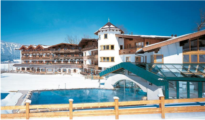
Das 4 **** Hotel „Kitzbühler Horn“ mit Außen/Innenschwimmbad
